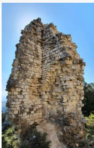
A sinistra Interno della torre del Castello di Monte Acuto
